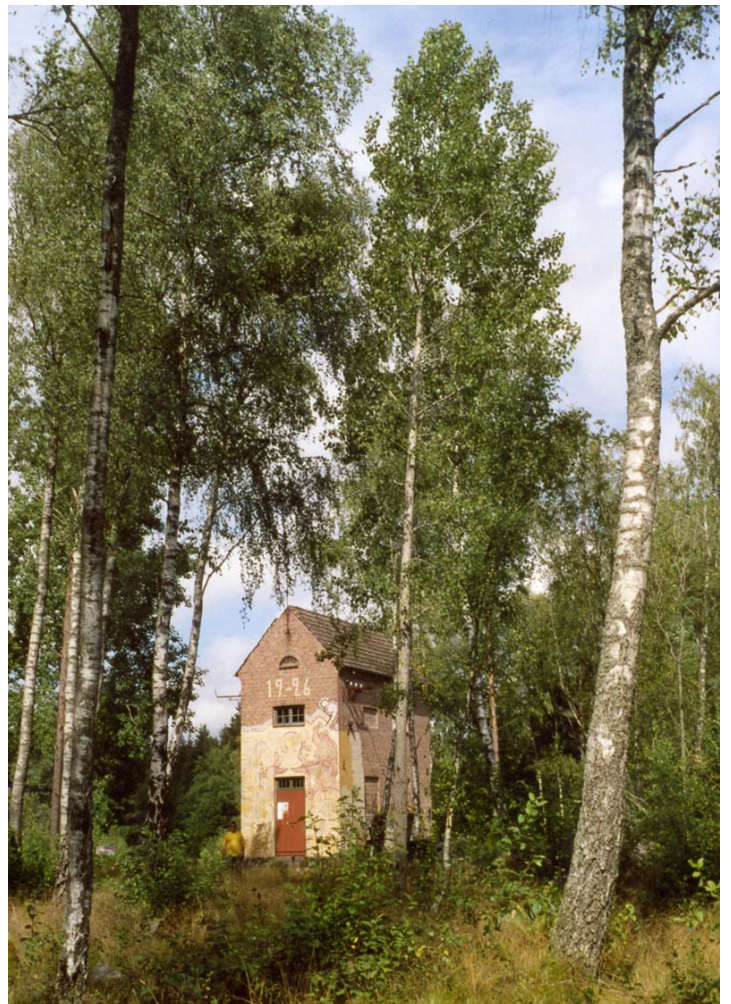
Transformator und Umgebung
